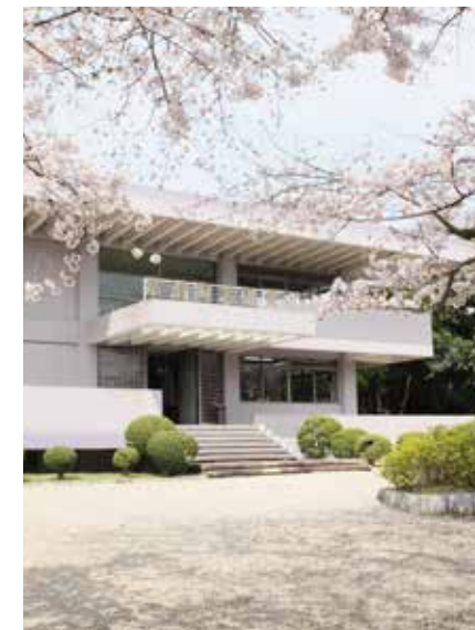
著名な建築家であり、茶の湯にも造詣が深い堀口捨己(ほりぐちすてみ)による設計。
