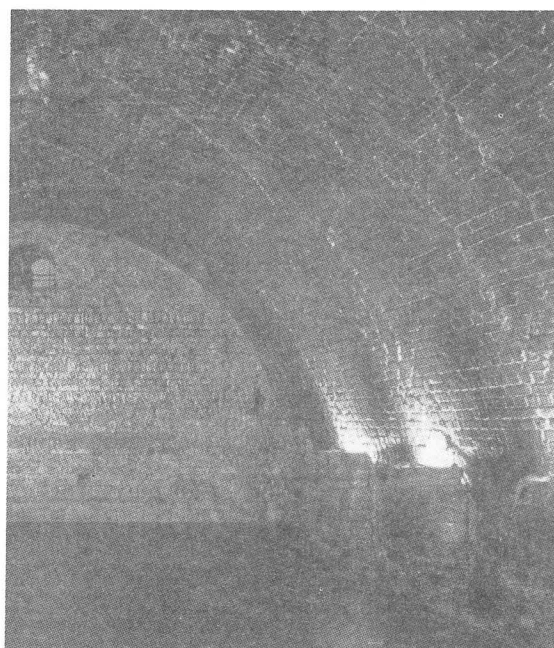
図26 石炭窯の内壁面 窯のある広場資料館 (3.18)
